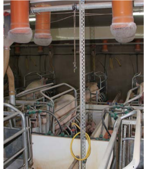
Das Haarnetz am Zuluftrohr für die Nasenlüftung mindert die Zugluft für die Sauen enorm
