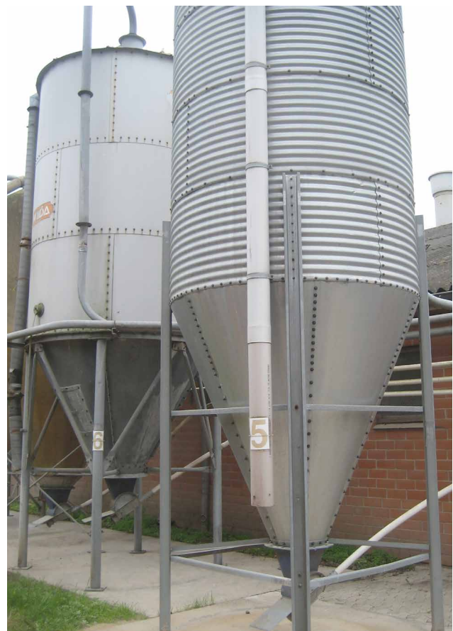
Das linke emaillierte Futtersilo ist über 30 Jahre alt und wasserdicht. Die Bleche sind noch nicht verrostet, nur die Schrauben sind ein wenig angelaufen. Rechts sieht man ein 10 Jahre altes feuerverzinktes Wellblechsilo.
