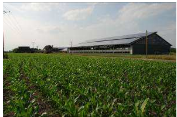
Auf den Dächern der Betriebsgebäude wurden seit 2007 PV-Anlagen mit 450 KWp Leistung installiert. Foto: J. H. Alberti
