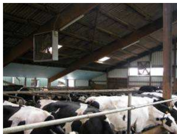
Leistungsfähige Ventilatoren liefern einen großen Beitrag, den Hitzestress für die Tiere abzumildern. Foto: Mahlkow-Nerge
