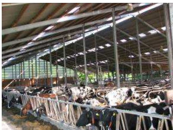
Selbst im neugebauten Außenklimastall in Futterkamp mit Traufenhöhen von 4 m wurde kaum eine Luftbewegung und folglich ein Kühleffekt für die Kühe wahrgenommen. Foto: Mahlkow-Nerge
