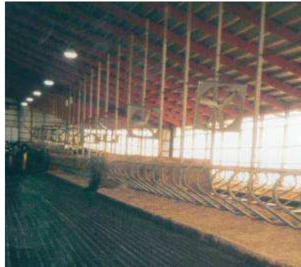
Ventilatoren in Reihe über den Mittelboxen sorgen für einen guten Luftwechsel und Luftbewegung. Foto: Anna Maria Miller
