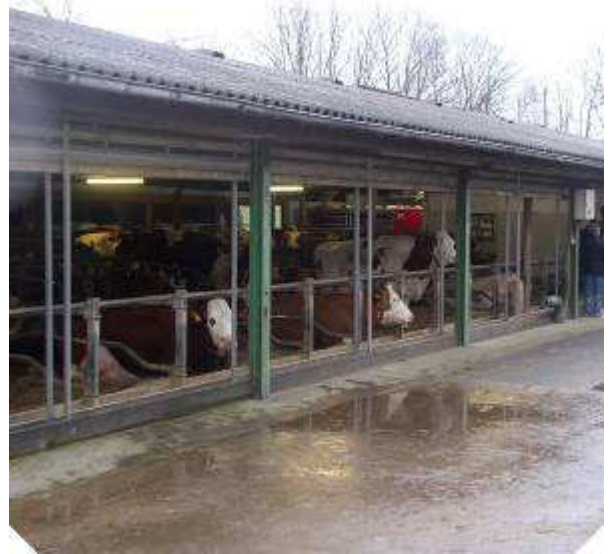
Bei diesem älteren Stall wurde die Außenwand komplett geöffnet. Die Kühe lieben es! Foto: Anna Maria Miller
