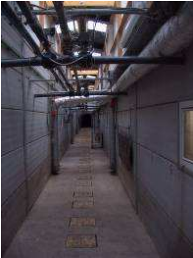
Abb. 2: indirektes Tageslicht aus Zentralgang. Foto: M. Weber
