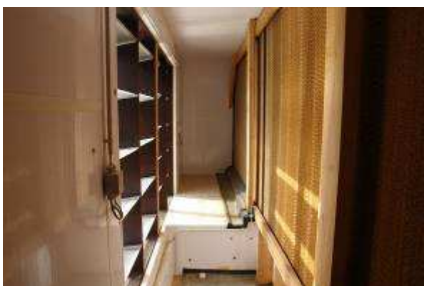
Abb. 2: Coolpads im zentralen Zuluftkanal. Foto: M. Weber
