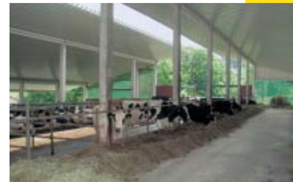
Blick in den neuen Zweidach-Offenstall
