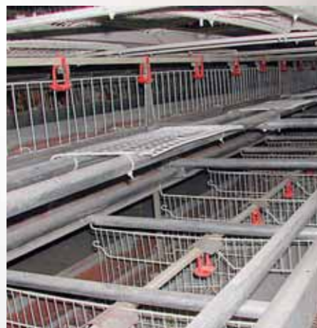
Bild 7: Rohbauphase mittlere u. untere Etage
