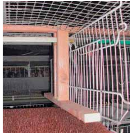
Bild 5: Darstellung NESTAUSTRIEB in der Rohbauphase
